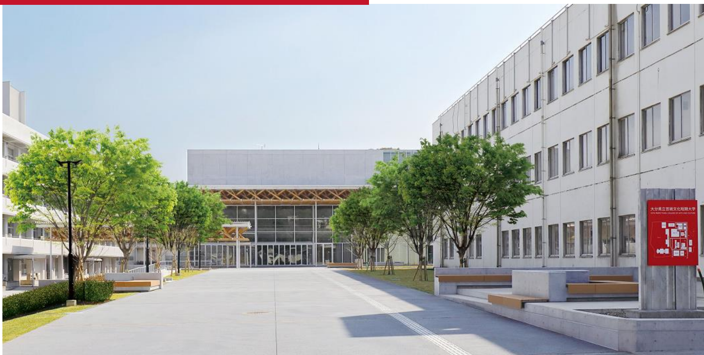
シンボルロードから臨む音楽ホール棟 平成31年2月 完成
